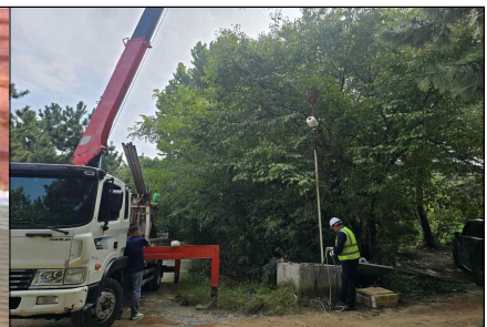
덕암야구장 내 공중화장실 급수설비 정비
