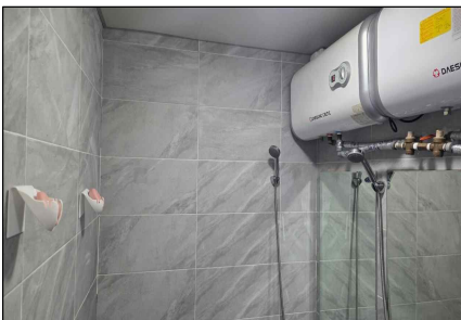
산디마을 오토캠핑장 전기공사
