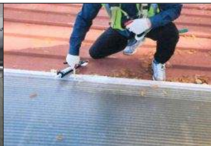
송촌전천후게이트볼장 누수 보수공사
