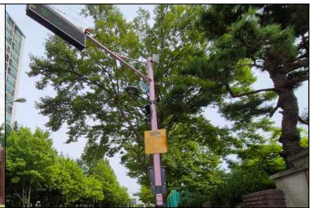
<지능형 CCTV 설치>
