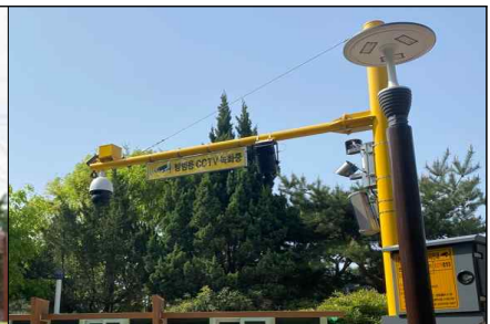
<스마트시 CCTV 설치>
