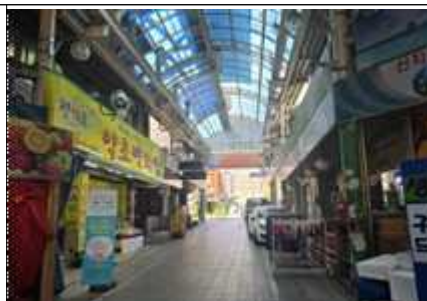
법동시장 폭염저감시설 설치
