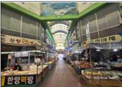
중리시장 폭염저감시설 설치
