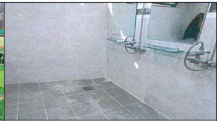
대덕문화체육관 남자샤워실 개보수
