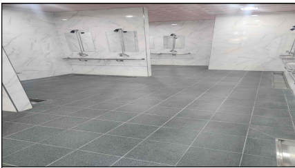
대덕국민체육센터 여자 샤워실 공사
