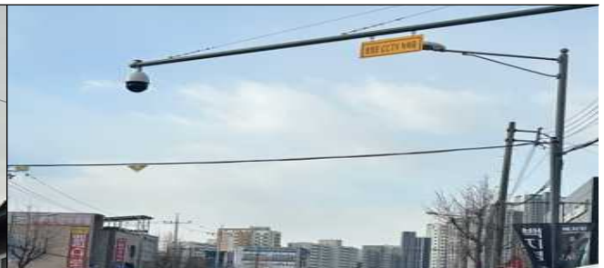
<방범용 CCTV 성능개선>
