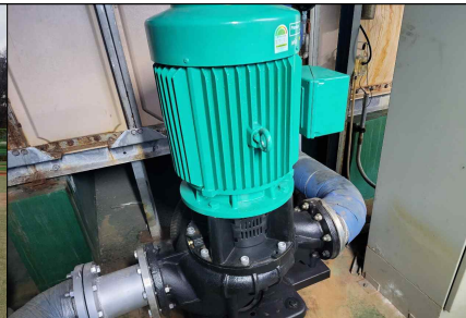
대덕국민체육센터 순환펌프 교체
