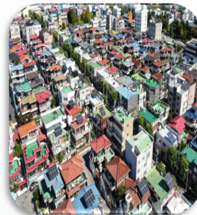
< 태양광 발전 설비 설치 전경 >
