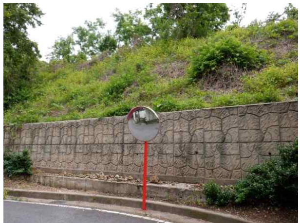
시점부 콘크리트 옹벽 전경
