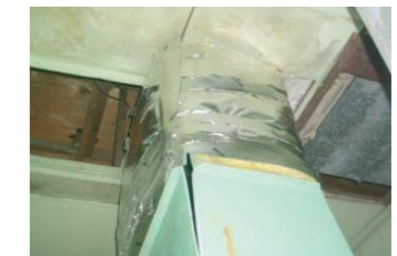
기타 손상부위 보수
